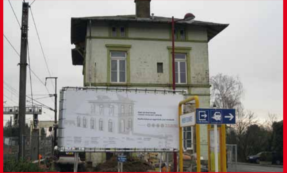
Renovierung Bahnhof Nörtzingen (6 Studentenwohnungen)
